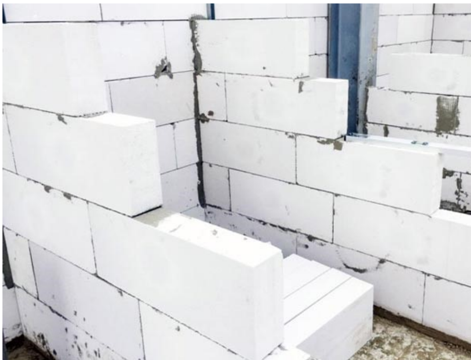
Фото 4. Кладка из ячеистых блоков.
