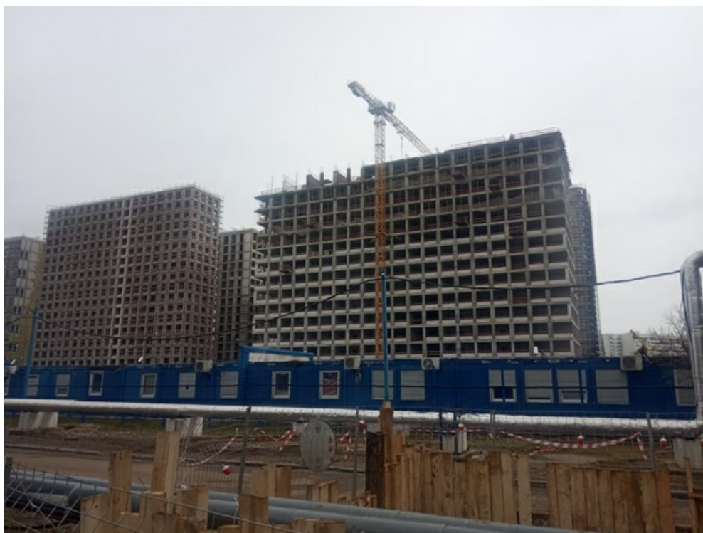
Рис. 1. Общий вид объекта строительства.
