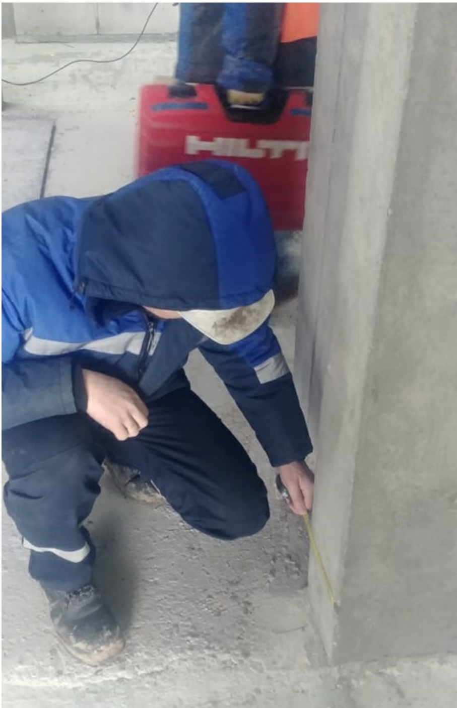
Рис. 4. Проверка отклонений длин вертикальных ж/б конструкций.
