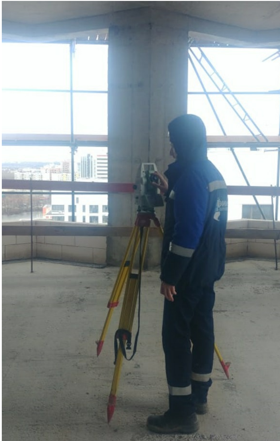
Рис. 3. Проверка отклонения линий плоскостей пересечения от вертикали на всю высоту конструкции.
