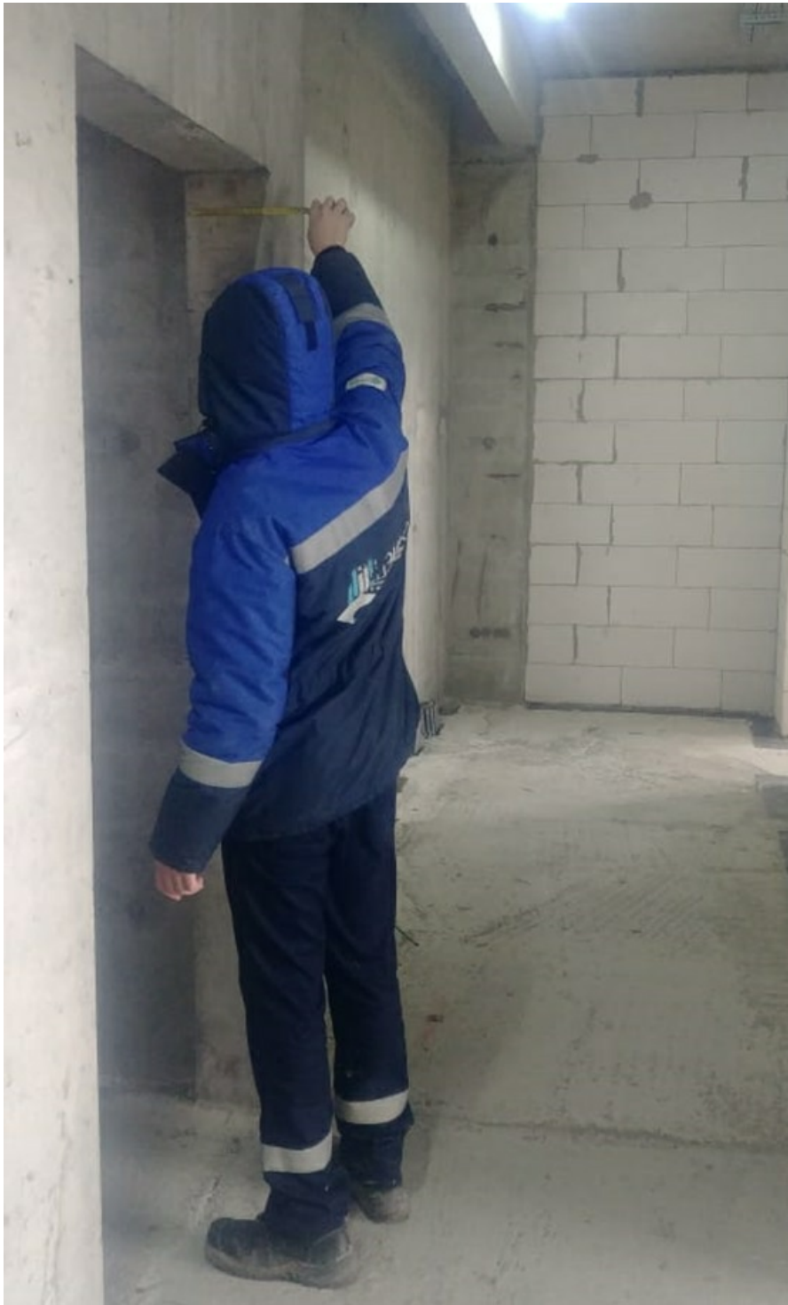
Рис. 2. Проверка геометрических параметров монолитных конструкций.
