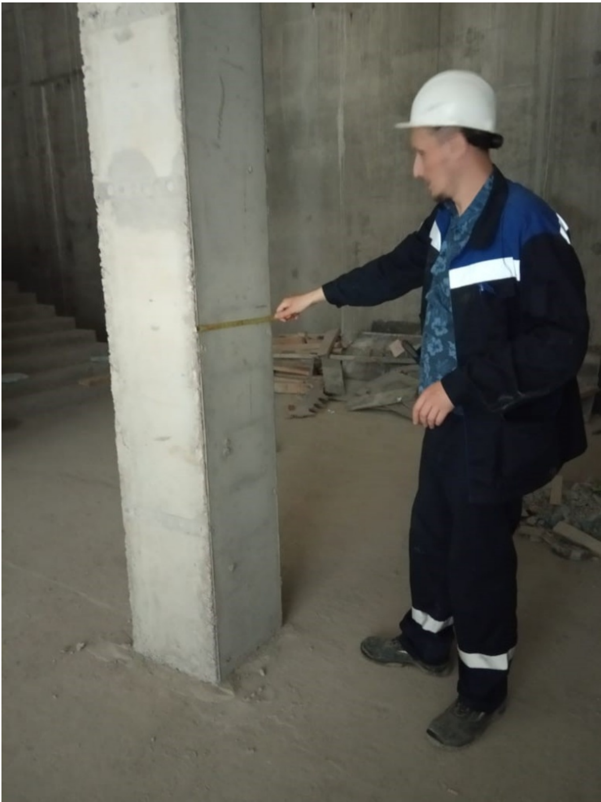
Рис. 2. Проверка соответствия размеров поперечного сечения элементов требованиям технических регламентов и проектной документации
