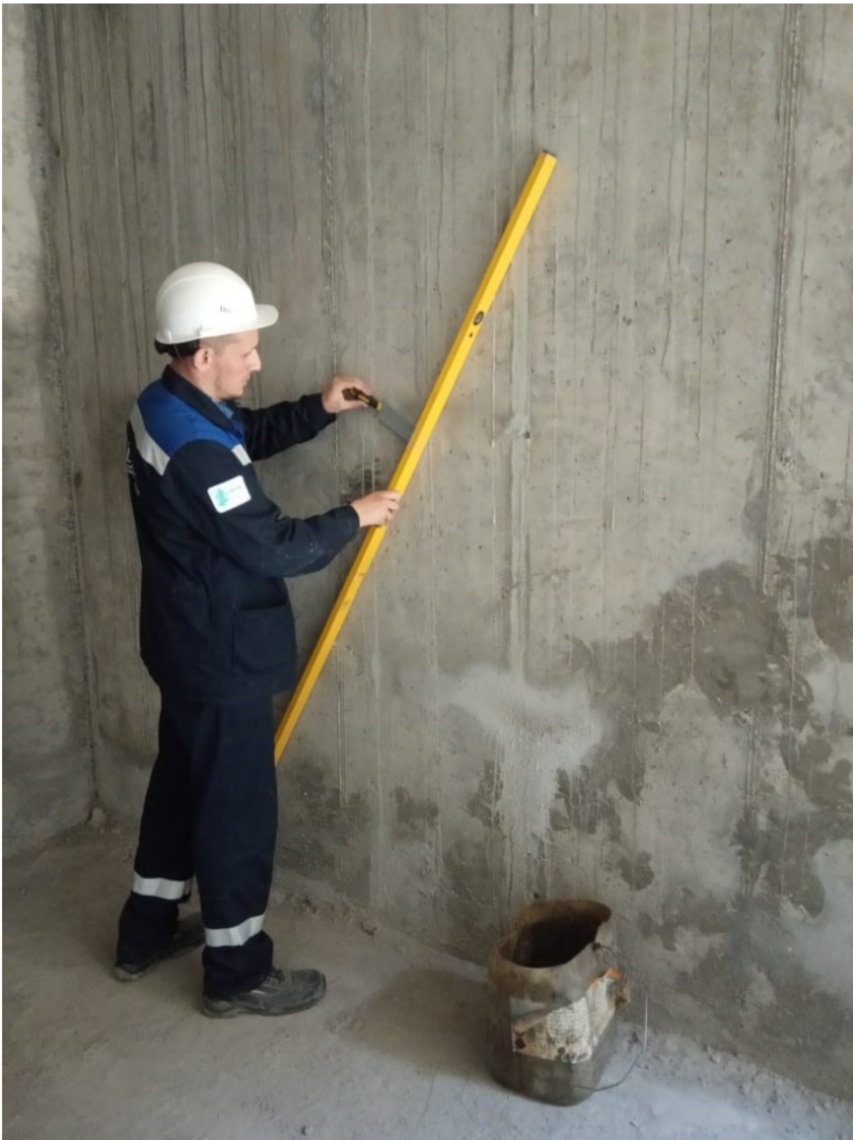
Рис. 1. Проверка прямолинейности поверхности на длине 1-3м и местных неровностей поверхности бетона
