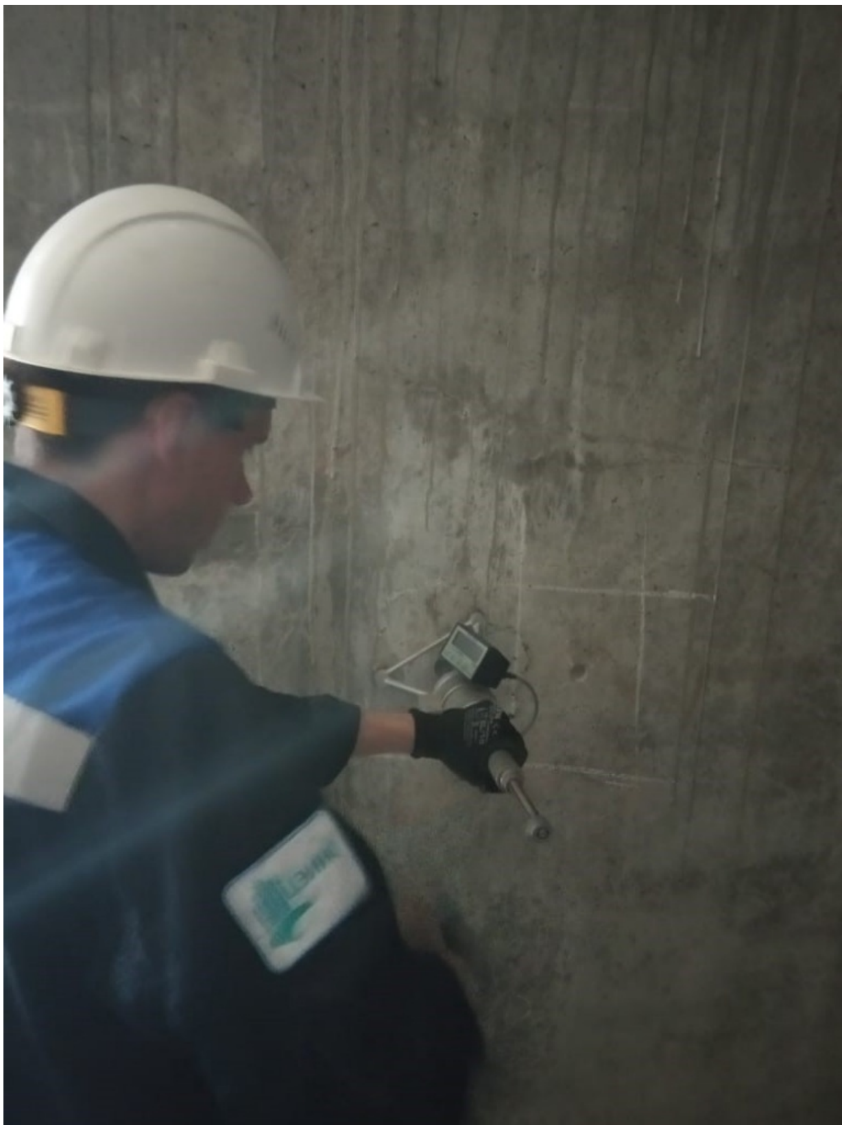
Рис. 4. Проверка соответствия класса бетона по прочности на сжатие требованиям технических регламентов и проектной документации.
