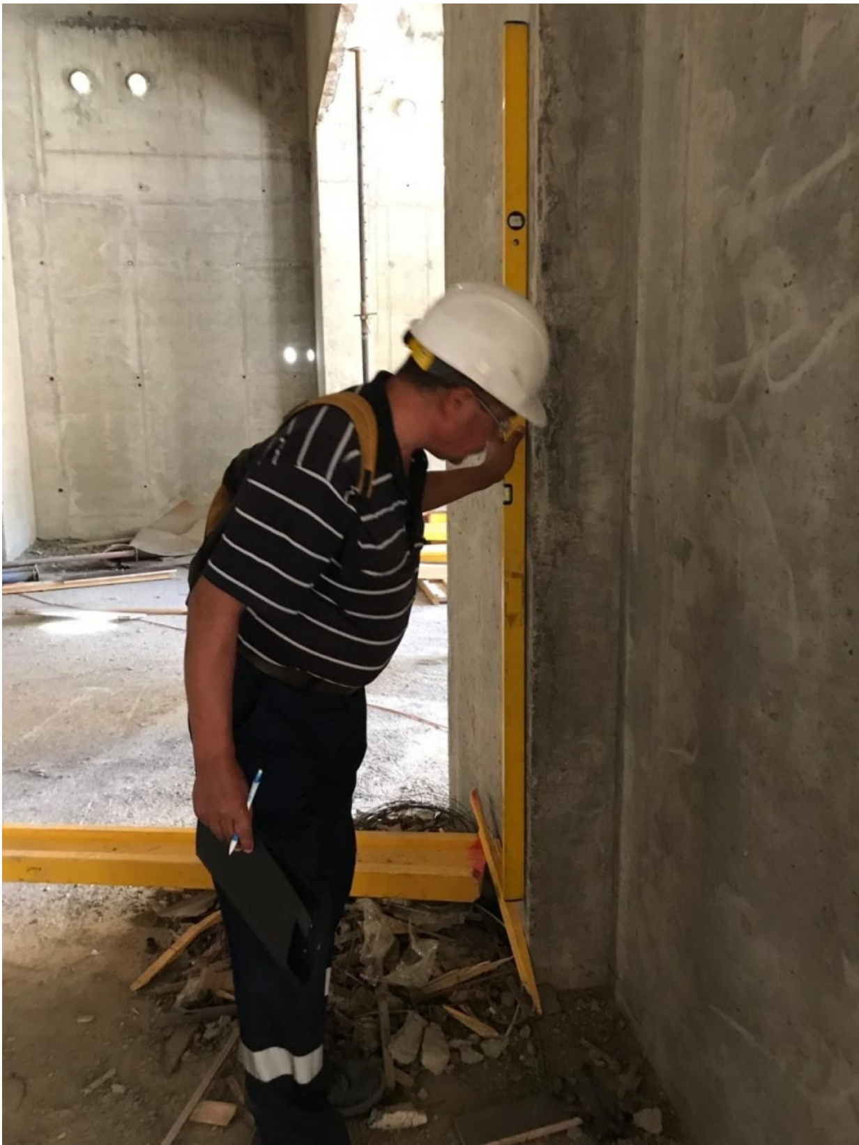
Фото 4 Проверка прямолинейности поверхности монолитных железобетонных конструкций.
