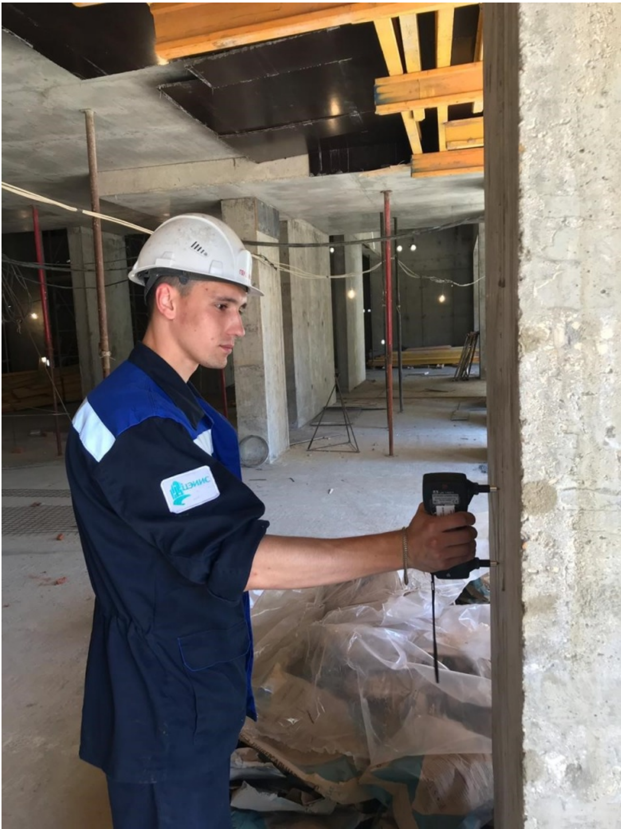
Фото 2,3. Проверка качества монолитных железобетонных конструкций
