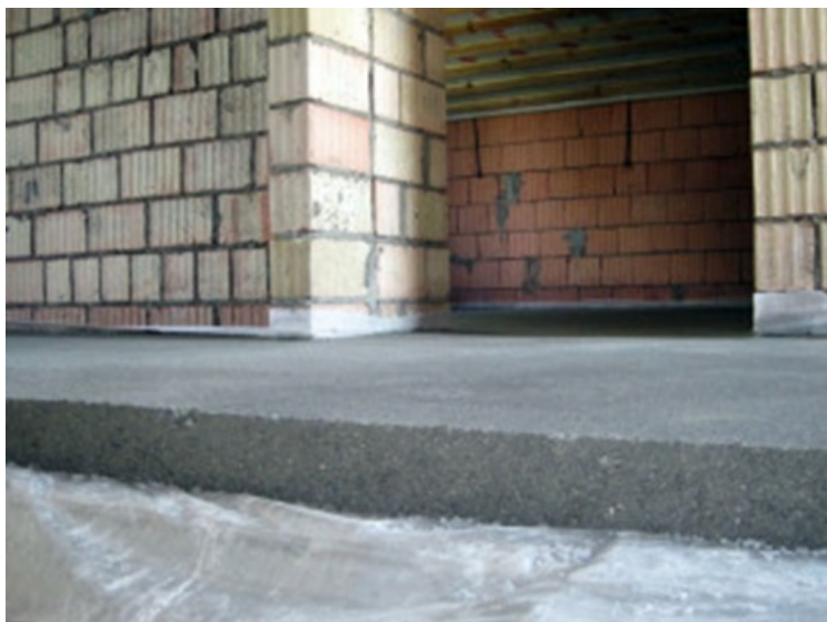
Фото 2. Стяжка пола с применением фиброволокна.
