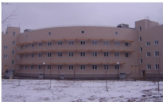
Фото 4. Общий вид обследуемого здания.
