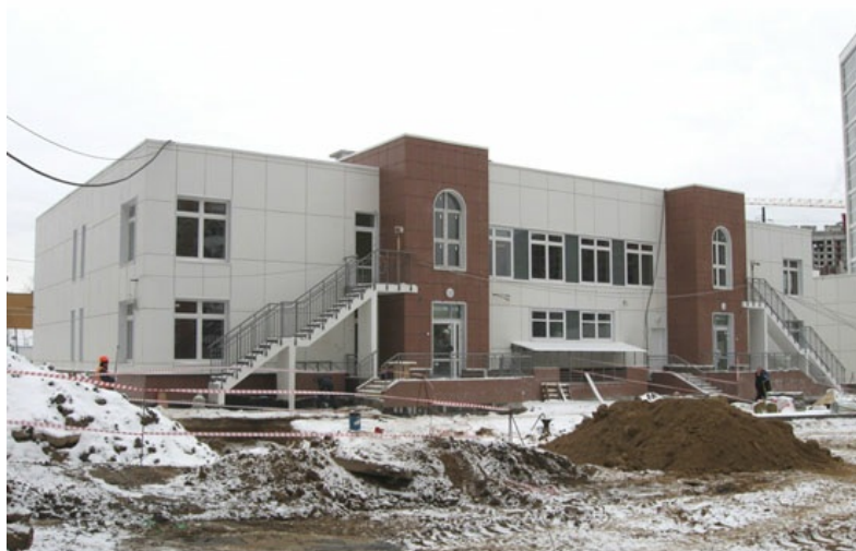
Фото 3. Общий вид обследуемого здания.
