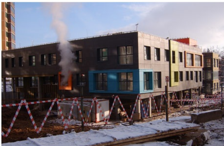
Фото 2. Общий вид обследуемого здания.
