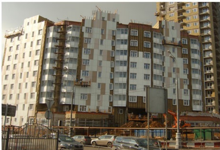
Фото 1. Общий вид обследуемого здания.
